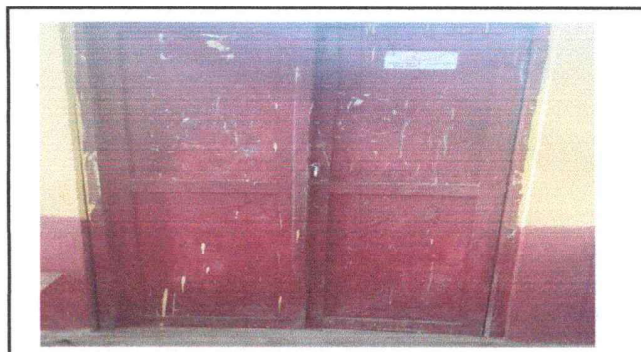
Foto 4: sustitucion de puerta de madera por puerta de metal
