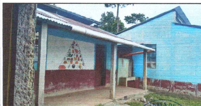
Foto 5: sustitucion de canales de agua pluviales
