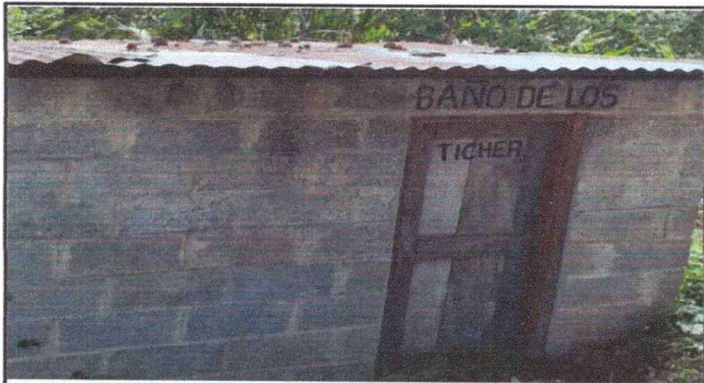
Foto 9: sustitución de laminas y puerta de madera, repello y pintura
