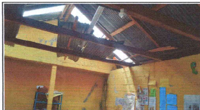
Foto 3: sustitucion de capote de madera por metal
